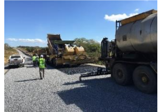
Rehabilitation of Road Malema Cuamba (114km)
