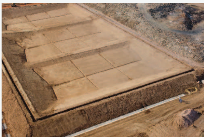
Fase II Aterro Industrial de Resíduos Perigosos de Mavoco
