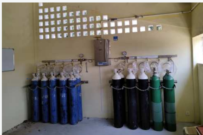
Canalização de Gases Medicinais no Hospital Distrital de Mocuba
