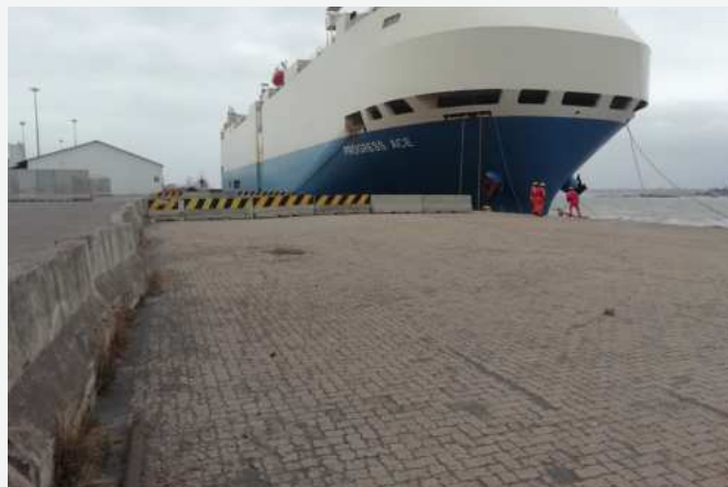
Inspeção Detalhada e Avaliação Estrutural dos CAIS 2, 3 e 4 no MPDC
