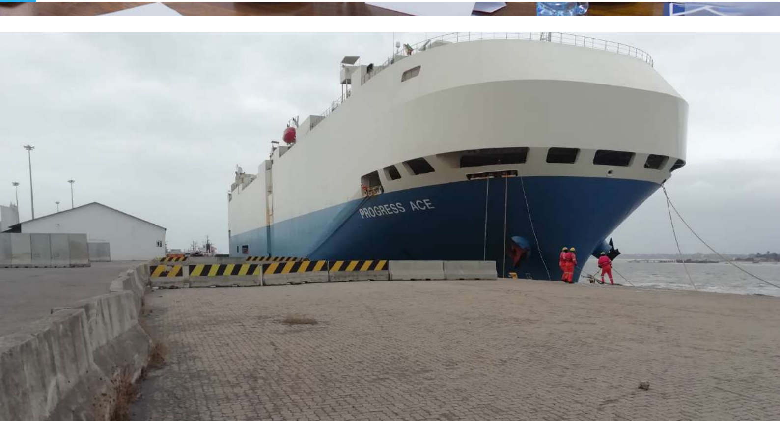
Inspeção detalhada e Avaliação Estrutural dos CAIS 2, 3, e 4 no Porto de Maputo (MPDC)
