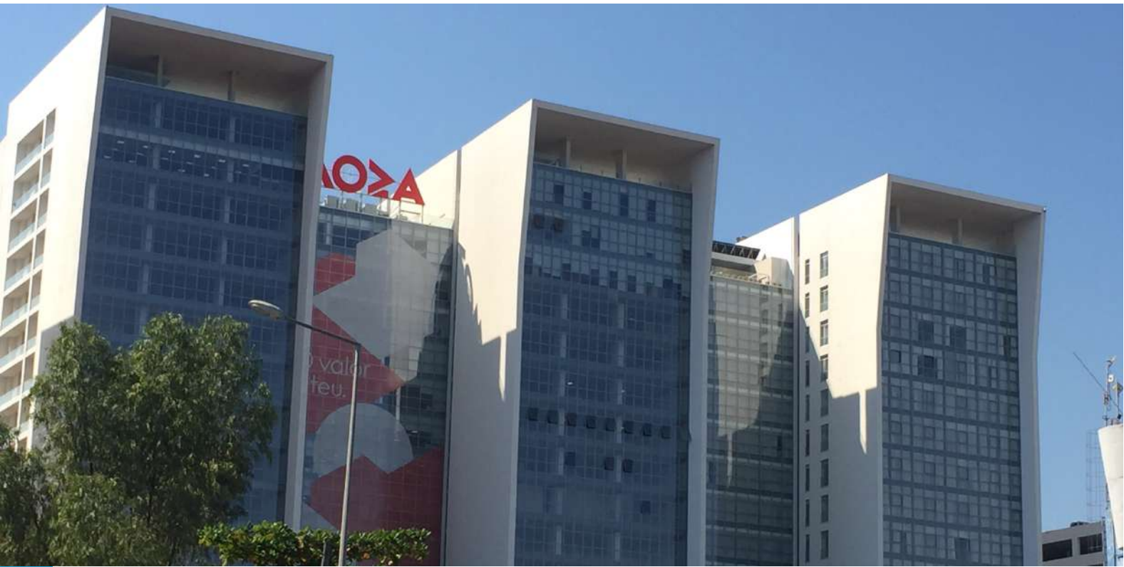
Prédio JAT VI - Cidade de Maputo
